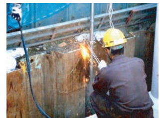
土木工事現場で活躍中
