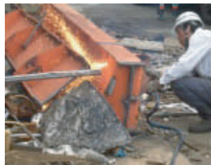
H鋼を容易に切断
