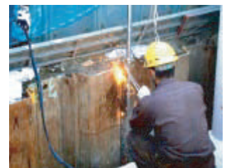
土木工事現場で活躍中
